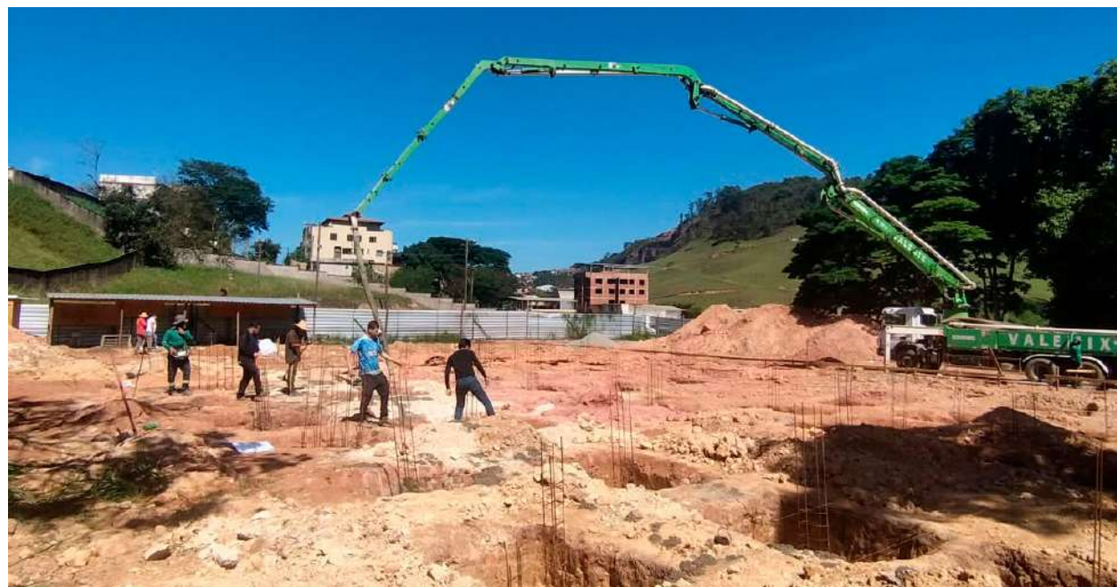
OBRAS NA UBS DO LOANDA exigem atenção técnica para garantir segurança e qualidade da construção
