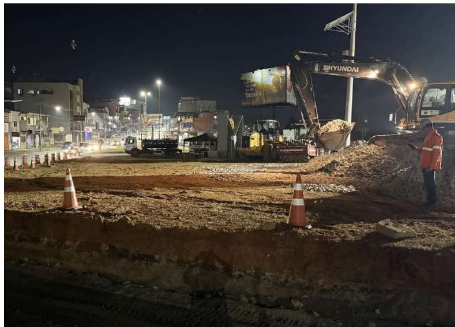
OBRAS no trevo do Cruzeiro Celeste são priorizadas no período noturno, mas os impactos na mobilidade urbana já são previsíveis
