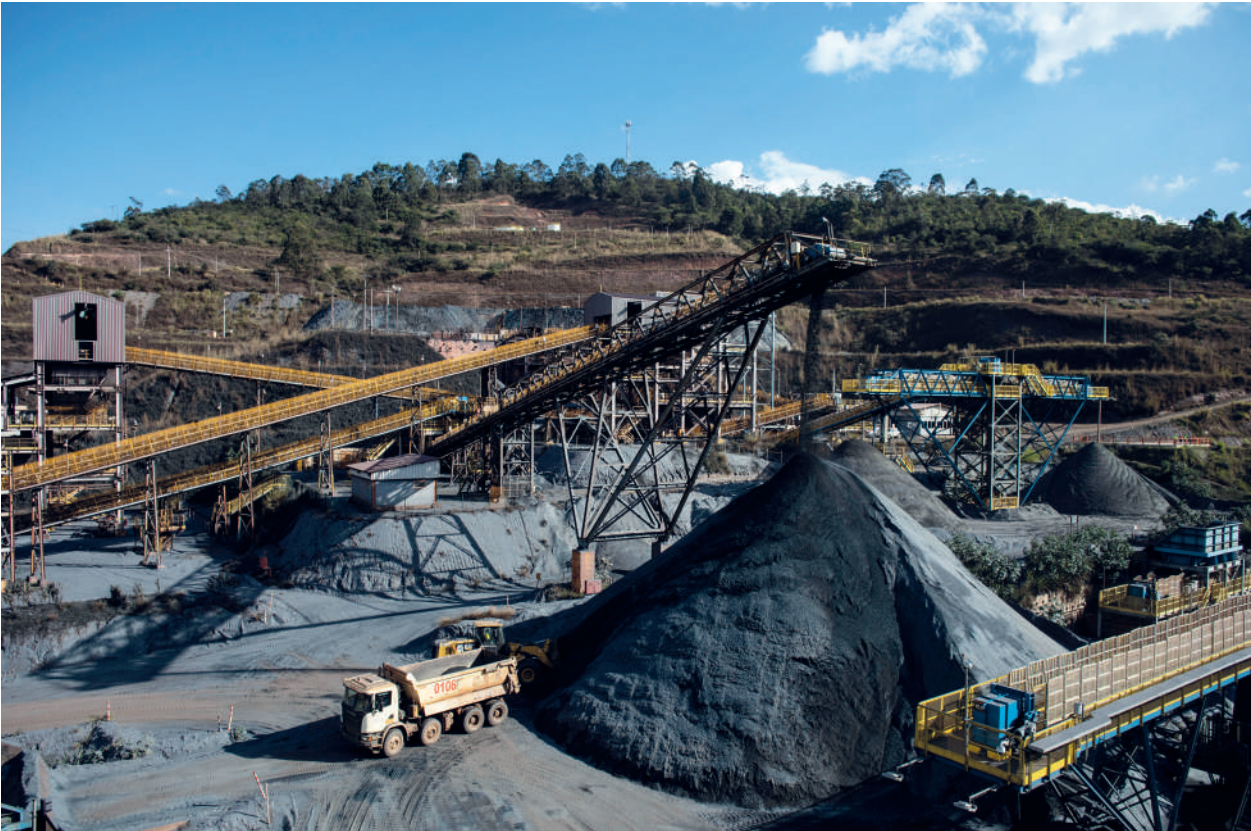
A MINA do Andrade tem toda a sua produção voltada ao abastecimento exclusivo da Usina de João Monlevade
