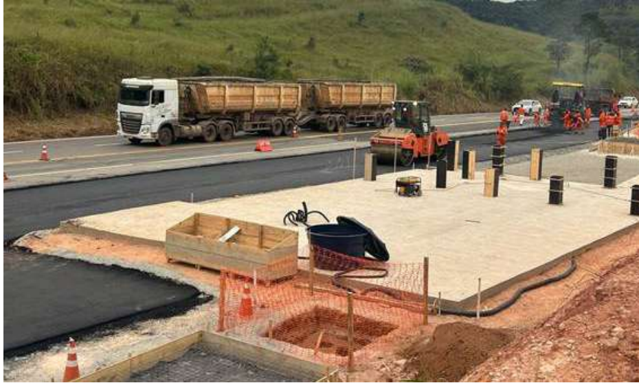
BASES DE SERVIÇO Operacional estão sendo montadas ao longo da BR-381
